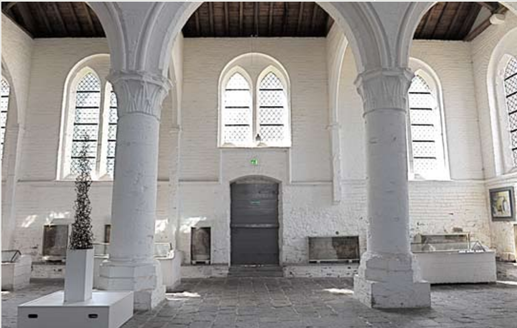
Afb.1 Zuidwand. Niveau van de vloer is lager dan het oorspronkelijke niveau
